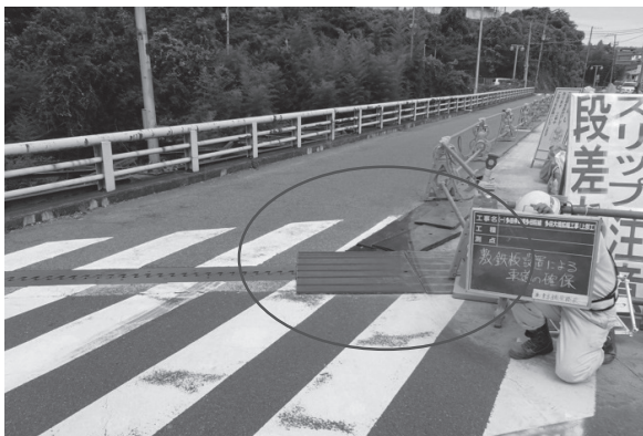
図-6 隅切り用敷鉄板
