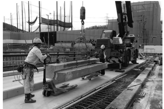
図-3 撤去部材の床版横持ち運搬状況
