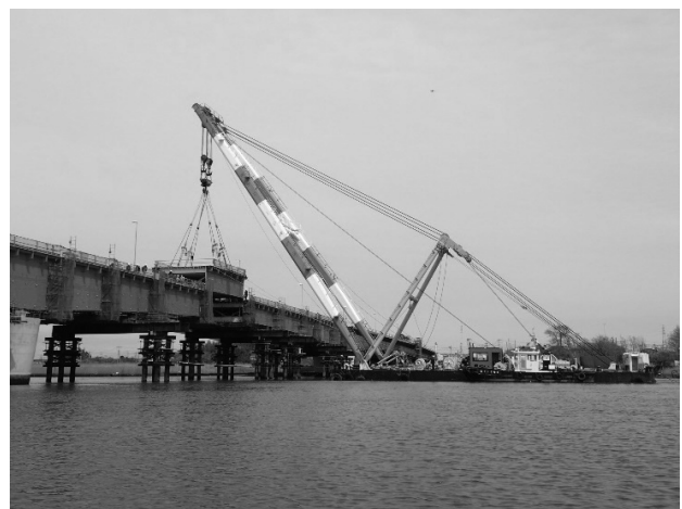
図-1 FC架設状況写真（閉合ブロック架設）
