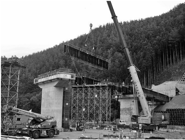
図-3 鋼桁の架設状況
