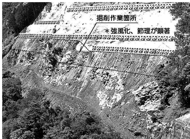
図-3 掘削作業箇所
