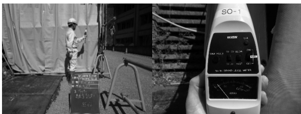
図-9 騒音計測状況
