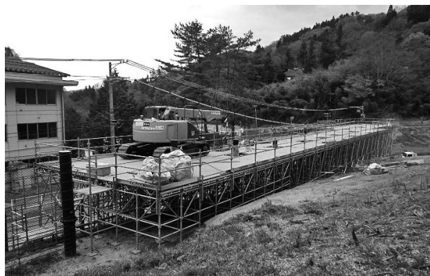
図-8 足場工全景
