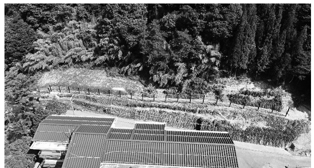
図-12 地域を守る崩壊土砂防止柵工
