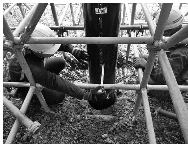
図-4 支柱固定作業
