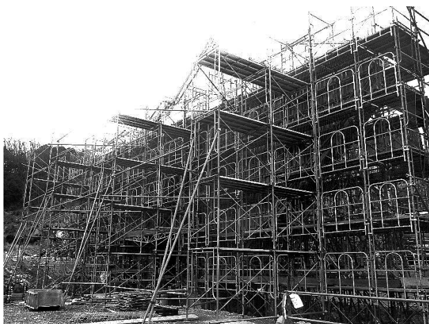
図-3 足場のバットレス補強
