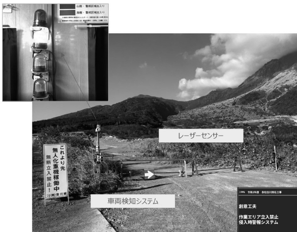
図-8 車両検知システム
