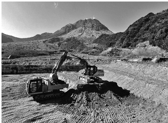
図-4 施工状況（現場側）
