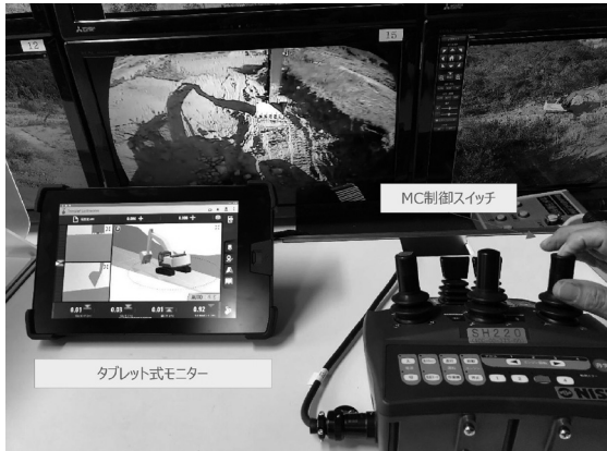
図-3 施工状況（遠隔操作側）
