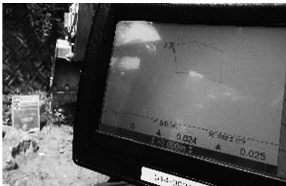
図-3 情報通信技術による機械掘削状況
