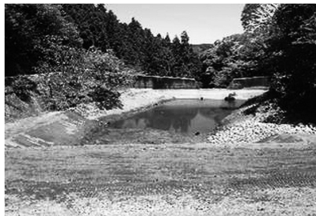
図-10 福德川砂防堰堤堆積土砂撤去工事完成
