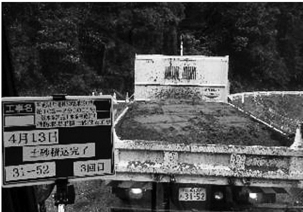
図-6 積込完了の後写真撮影状況その2
