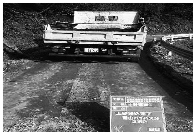
図-5 積込完了の後写真撮影状況その1
