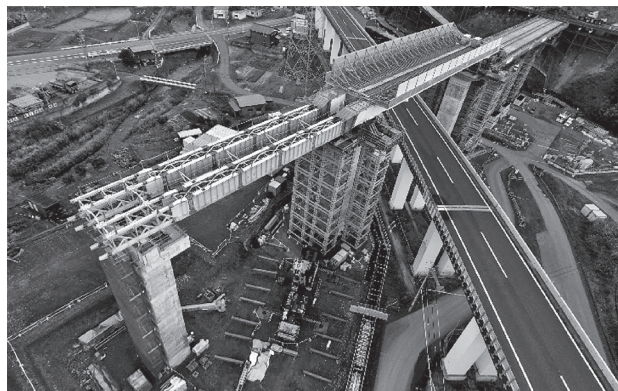
図-5 送出し完了写真
