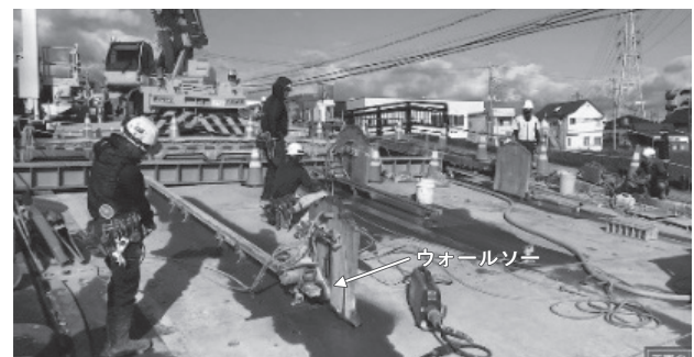
図-6 床版切断状況
