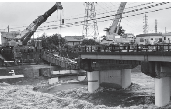
図-11 濁水下での本橋撤去(8/15)
