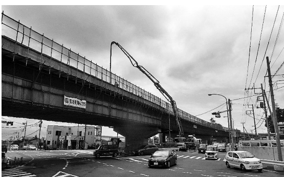
図-10 P8～A2コンクリート打設状況
