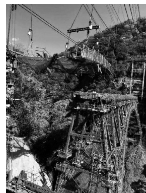
図-8 旧橋撤去状況
