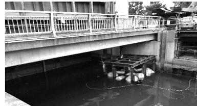
図-11 潜水士による仮設架台の設置
