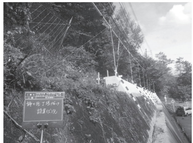
図-6 落石防護柵 施工用丁張設置
