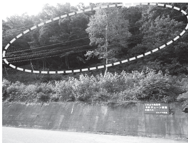
図-2 施工箇所直上 架空線
