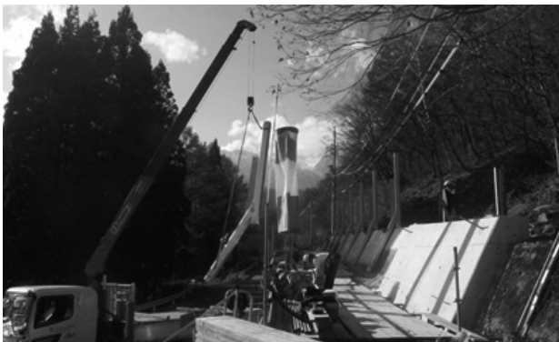
図-9 落石防護柵 支柱設置
