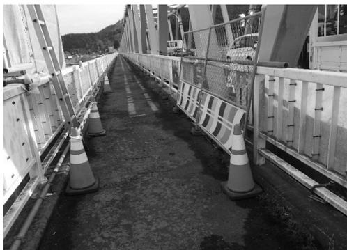
図-2 地覆撤去箇所フェンス設置
