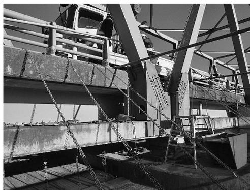
図-1 補強材設置作業
