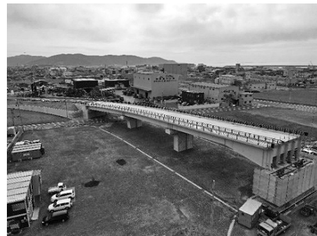
図-5 工事完成(鎮守大橋 左岸)
