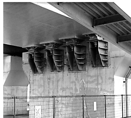
図-4 落橋防止ブラケット設置完了
