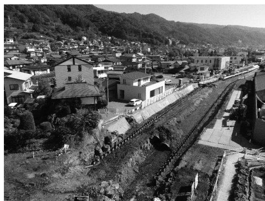
図-4 矢板設置完了
