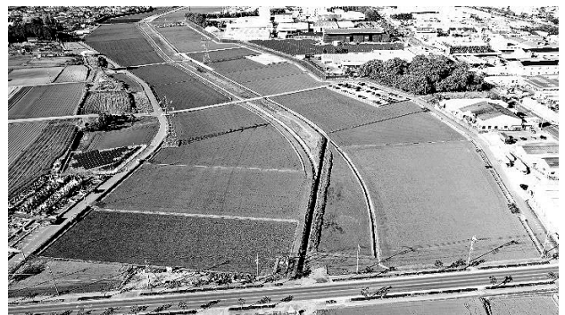
図-3 現場状況 (完成)
