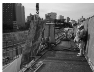
図-3 ワイヤソー切断状況
