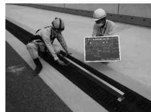
図-9 縦目地平坦性確認状況
