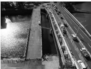
図-6 固定規制状況
