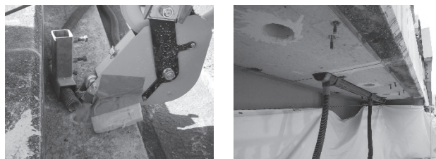
図-4 ワイヤソー切断部養生状況
