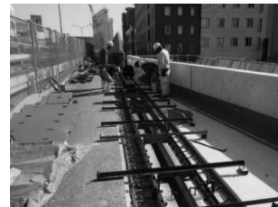
図-8 縦目地据付状況
