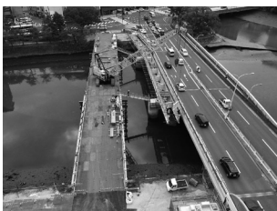
図-5 主桁部架設状況
