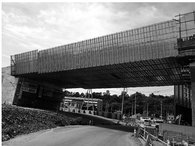
図-2 足場、防護組立全景
