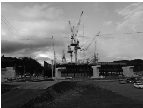
図-1 現場施工前状況（鎮守大橋右岸）
