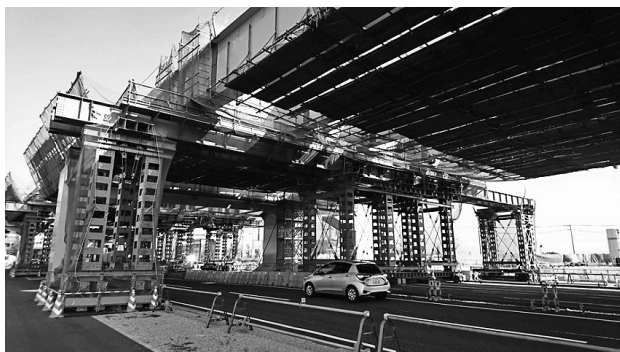
図-1 現場施工状況
