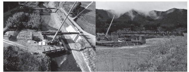
桁架設状況 (大雨前) 桁架設状況 (大雨後)
