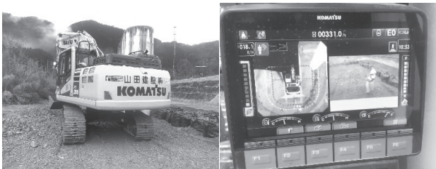
図-3 「人検知衝突軽減システム搭載型」重機使用
