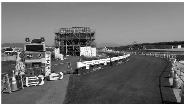
図-3 仮設ガードレール、行動点对策
