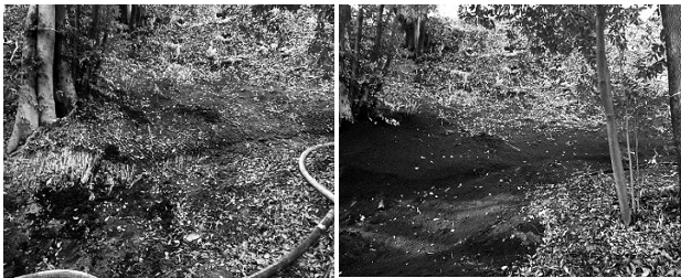
図-3 施工前と吹付後
