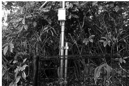
図-4 分電盤の設置
