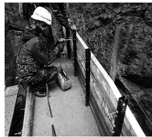
図-5 残存型枠組立
