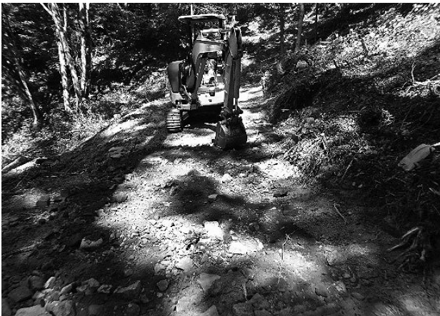
図-4 仮設道路作成、山砕敷均し
