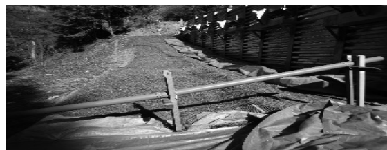
図-2 クラック発生箇所に伸縮計設置
