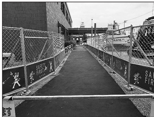
図-4 仮舗装による仮設通路
