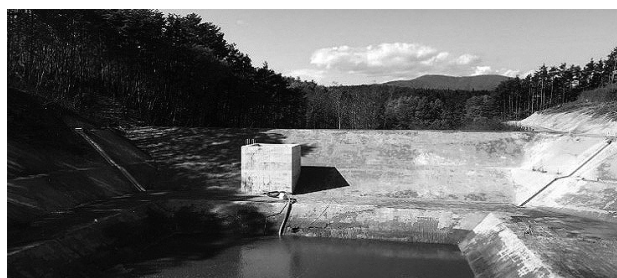
図-3 堤体盛土完了
