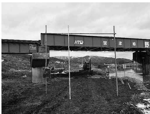
図-3 通行時安全確認ゲート設置
