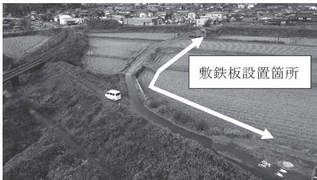
図-1 河川下流側生活道路
