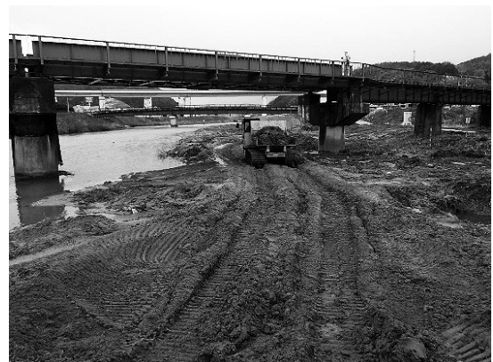
図-5 残土小運搬（不整地運搬車）
