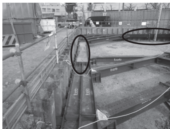
図-1 高強度腹起し設置
