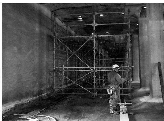
図-4 梁足場支保工上部ステージ化
