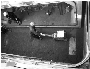
図-6 基礎コンクリート施工状況
