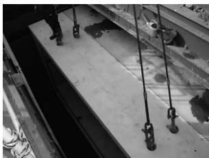
図-7 ボックスカルバート布設状況
