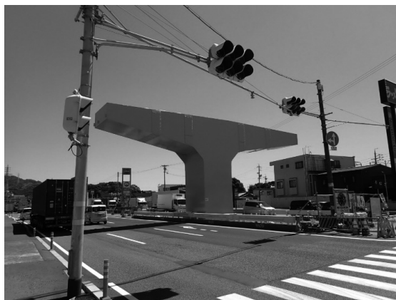
図-4 完了時全景(西側から撮影)
