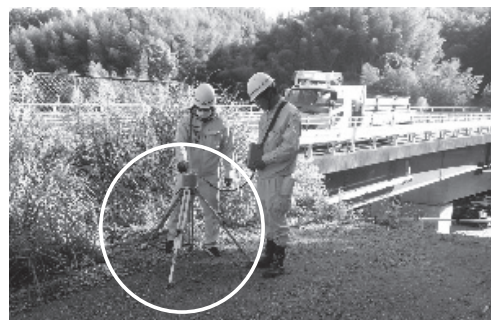
図-2 簡易支持力測定状況
