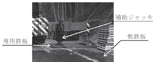
図-5 専用鉄板敷設状況
