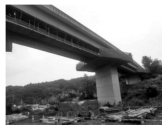
図-2 橋脚周り吊足場全景
