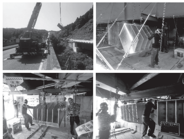
図-6 架設状況写真
