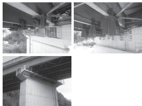
図-3 施工完了写真
