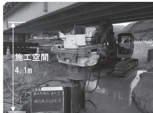
図-5 施工写真 (CHV工法)
