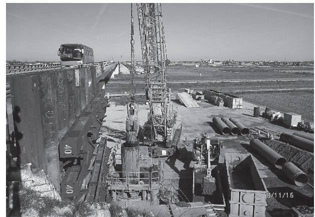
図-2 場所打ち杭近接施工状況
