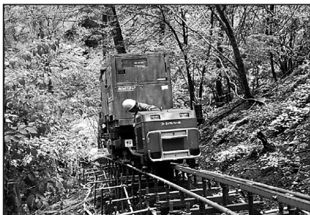
図-3 3tモノレール運搬状況
