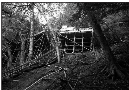
図-4 仮設足場状況
