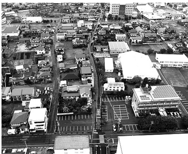
図-1 施工箇所着手前
