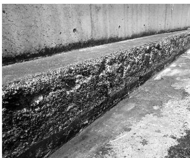
図-2 塩カルによるコンクリートの剥離及び鉄筋腐食状況
