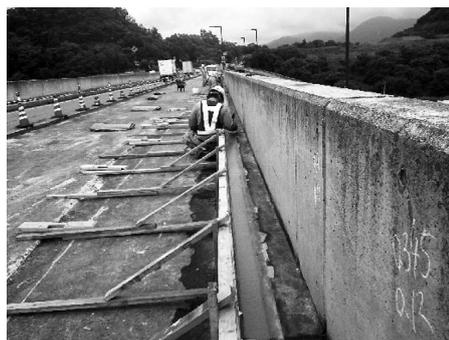
図-4 コンクリート打設状況
