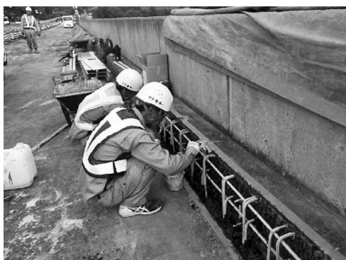
図-3 鉄筋防錆材塗布状況
