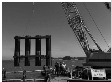
図-6 ユニット(腹起+鋼矢板-歯抜け-)据付状況
