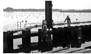
図-7 鋼矢板の海上打設状況(歯抜け部)
