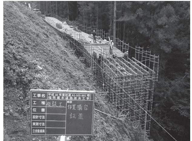
図-4 法面作業構台の組立
