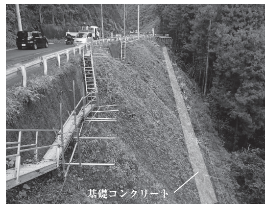
図-1 急傾斜地の施工箇所
