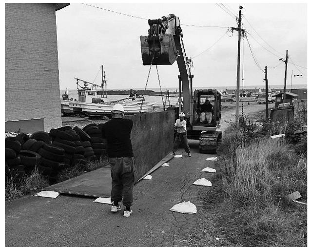
図-1 敷鉄板の敷設作業
