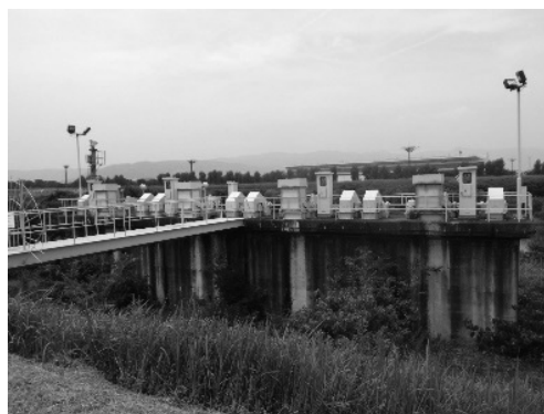
図-3 クレーン配置計画箇所(着工前)
