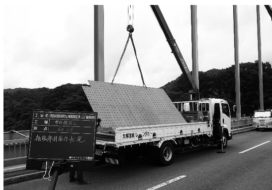
図-4 小型移動式クレーンによる吊り込み作業図
