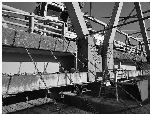
図-1 補強材設置作業
