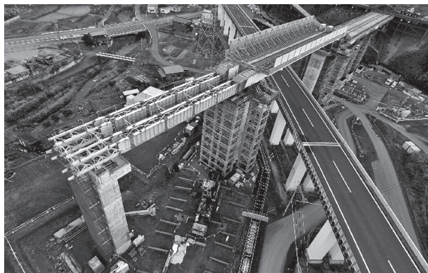
図-5 送出し完了写真
