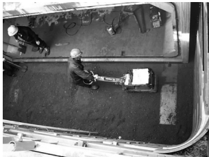
図-6 基礎コンクリート施工状況
