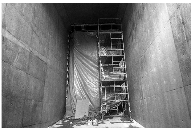
図-8 内空締め切り（ブルーシート）
