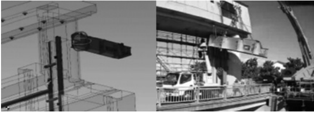
図-12 シミュレーションと実際の施工状況
