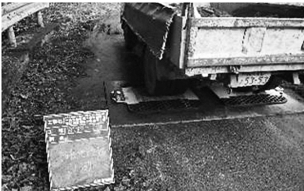
図-7 重量計による管理の様子
