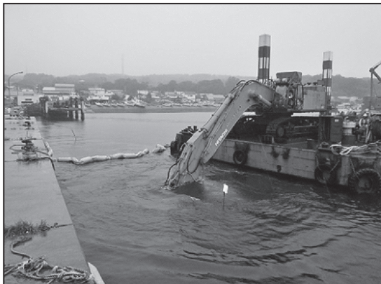
図6 GNSSによる施工状況
