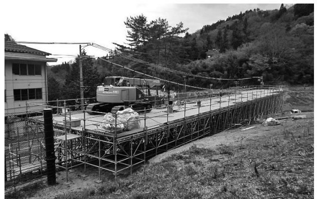
図-8 足場工全景
