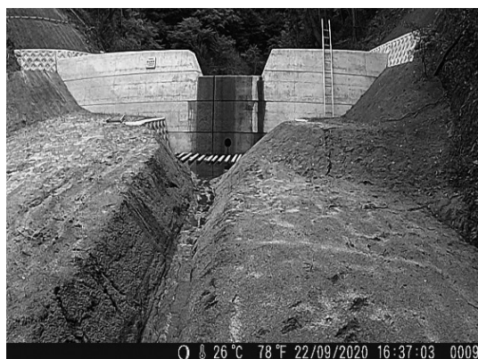
図-3 実際の映像①【治山ダム工】
