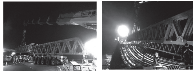
図-12 応急組立橋 地組・架設状況
