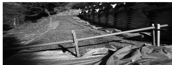
図-2 クラック発生箇所に伸縮計設置
