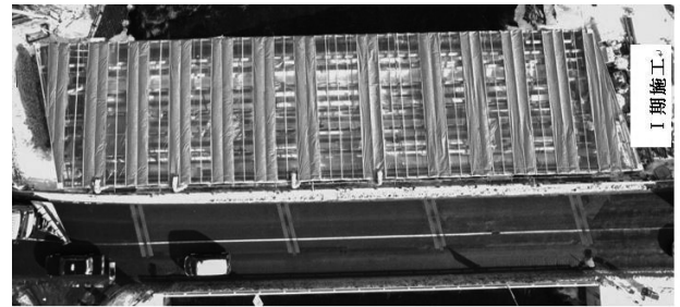
図-11 上屋全景（透明部がビニールフィルム）
