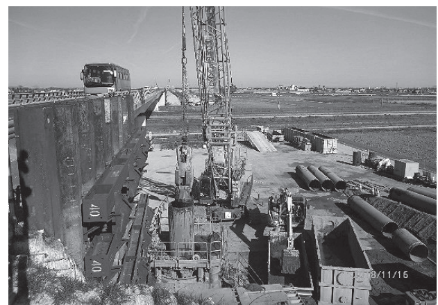
図-2 場所打ち杭近接施工状況
