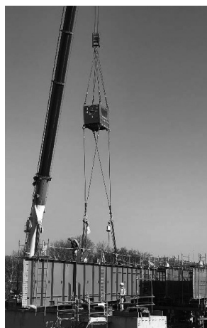
図-3 吊り荷制御状況
