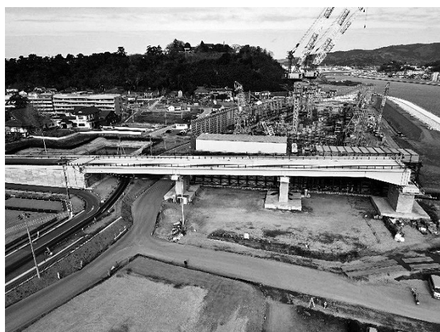
図-4 工事完成（鎮守大橋 右岸）
