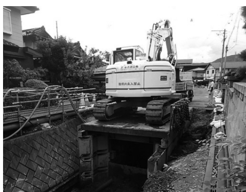
図-3 オープンシールド機施工状況
