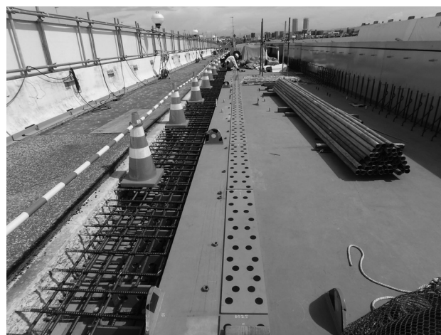
図-4 本締め完了後
