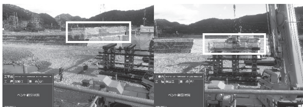
図-4 ベント組立時、高所作業低減対策
