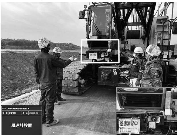
図-4 作業員に対して風速パトライト
