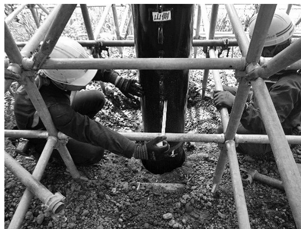
図-4 支柱固定作業
