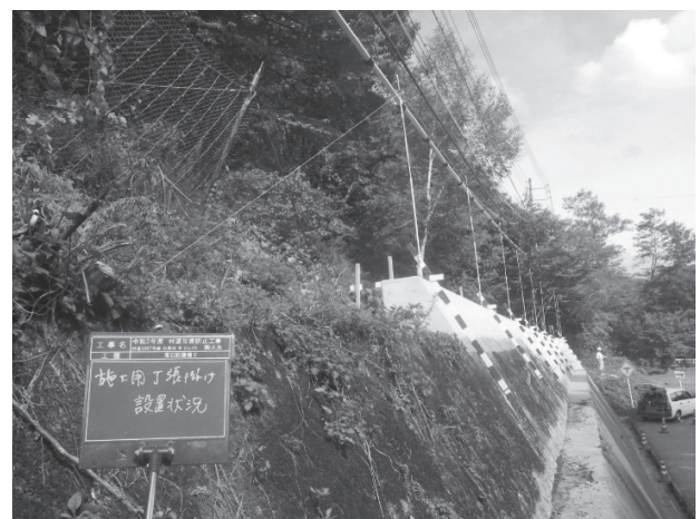
図-6 落石防護柵 施工用丁張設置
