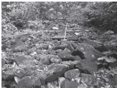
図-1 施工箇所村道上部斜面 露岩斜面
