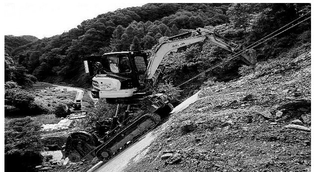
図-4 (ワイヤー架設にて不安定岩塊除去)
