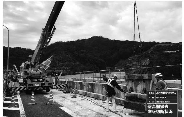
図-6 既設床版・壁高欄の撤去
