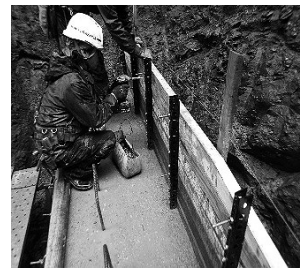
図-5 残存型枠組立
