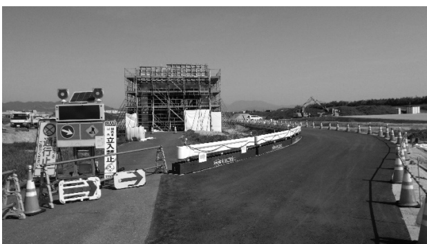
図-3 仮設ガードレール、行動点对策
