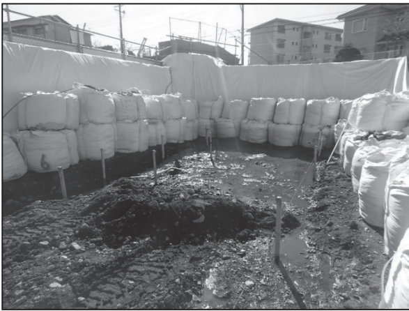
図-2 防災シートおよび大型土のう設置完了
