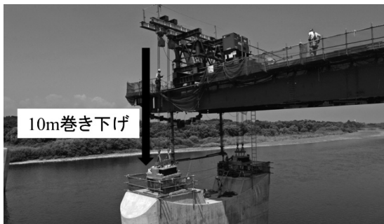
図-3 支承据付状況
