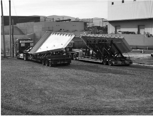
図-2 主桁運搬状況
