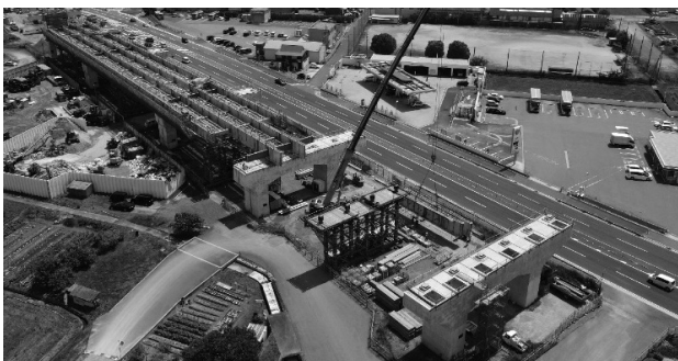
図-1 大和御所道路 曲川高架橋
