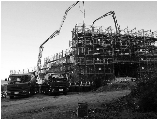
図-6 コンクリート打設状況
