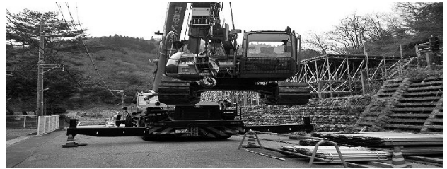
図-7 クローラークレーンつり込み状況
