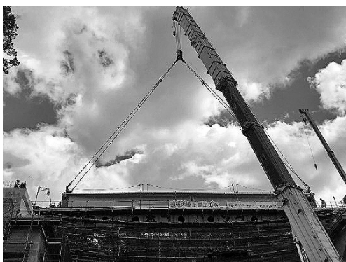
図-2 クレーンによる主桁の架設
