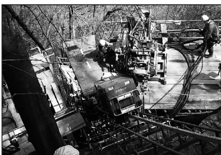
図-5 削孔機搬入状況
