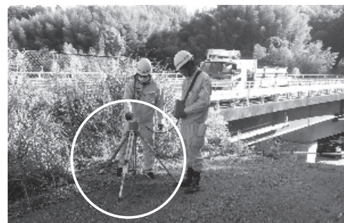
図-2 簡易支持力測定状況
