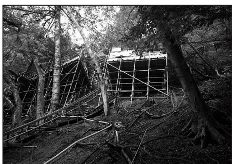
図-4 仮設足場状況
