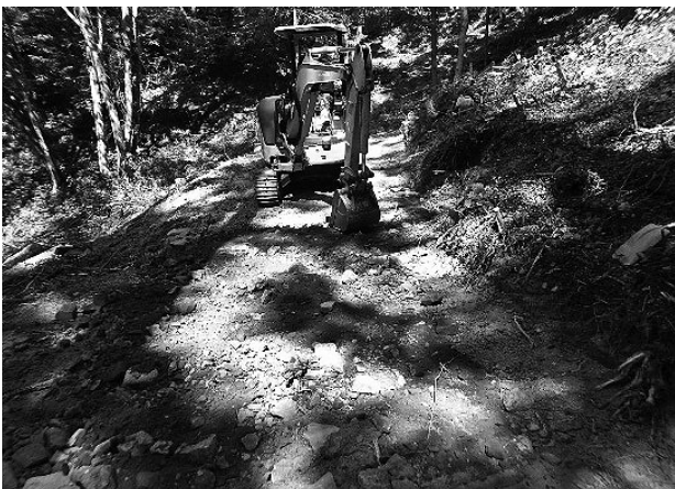
図-4 仮設道路作成、山砕敷均し
