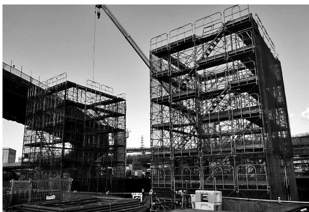
図-3 昇降設備の先行組立状況
