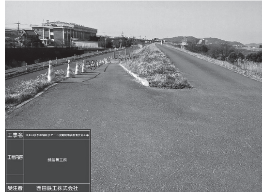
図-8 堤防道路への進入路
