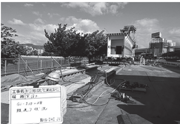
図-3 桁の縦送り
