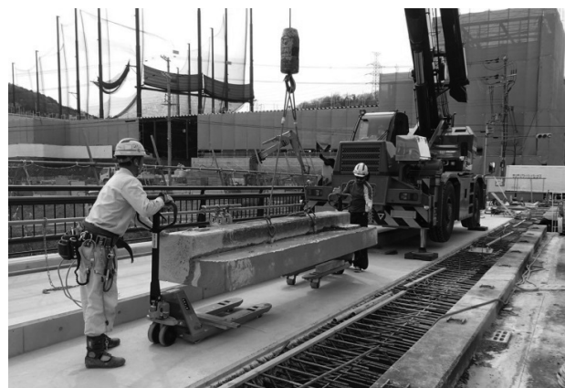
図-3 撤去部材の床版横持ち運搬状況
