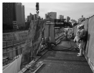
図-3 ワイヤソー切断状況
