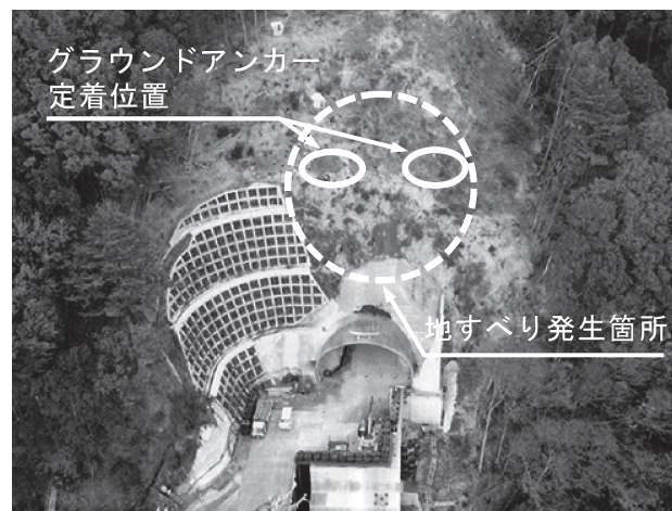
図-1 グラウンドアンカー定着位置
