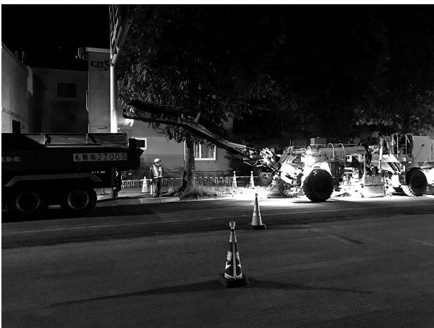
図-2 マシンコントロールによる切削状況
