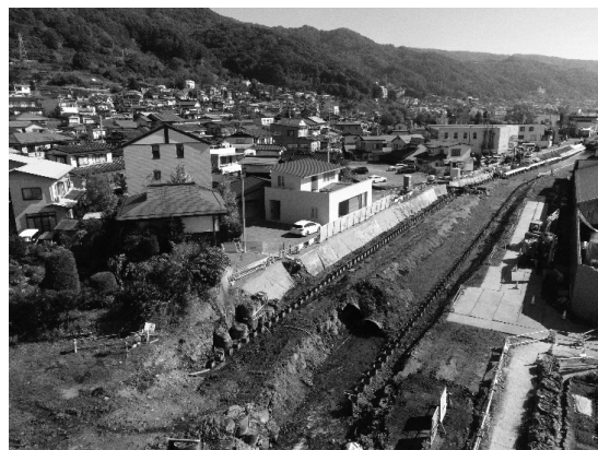
図-4 矢板設置完了
