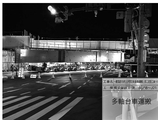
図-7 多軸台車による運搬
