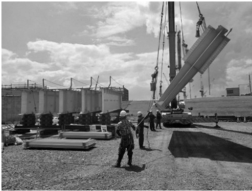
図-3 主桁荷降ろし状況
