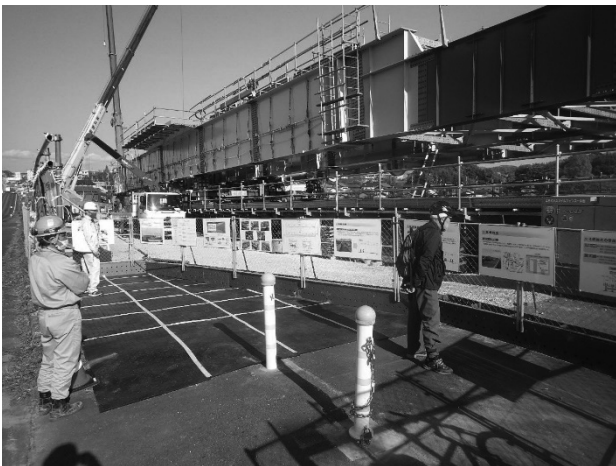
図-6 送出しヤードの施工状況
