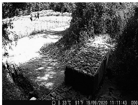
図-4 実際の映像②【土留工】
