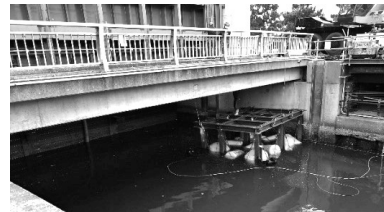
図-11 潜水士による仮設架台の設置
