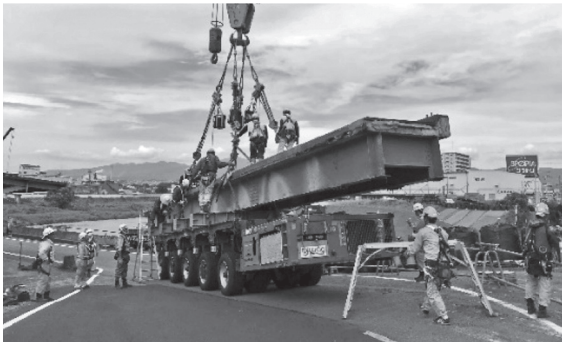
図-10 多軸台車搭載状況(側道橋)
