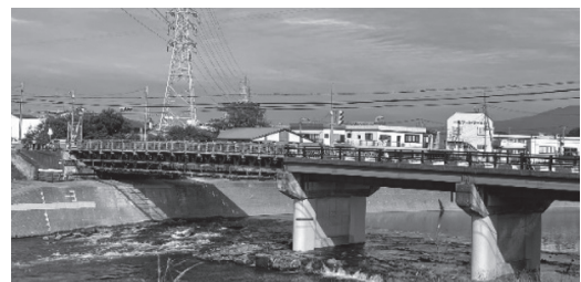
図-13 仮橋完成・開通
