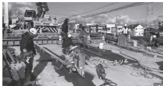
図-6 床版切断状況
