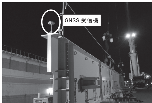
図-2 GNSS受信機設置状況
