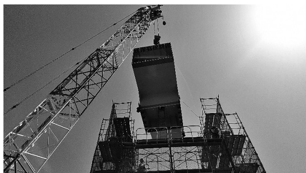
図-5 実際の架設状況
