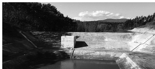
図-3 堤体盛土完了
