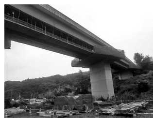
図-2 橋脚周り吊足場全景
