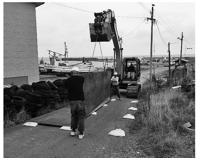
図-1 敷鉄板の敷設作業
