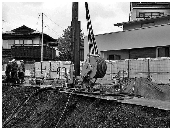
図-3 油圧式圧入機による圧入
