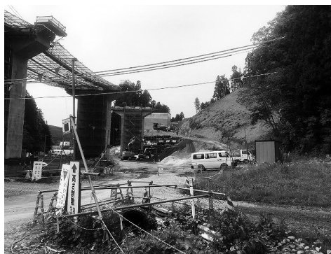
図-1 浪板大橋施工前状況
