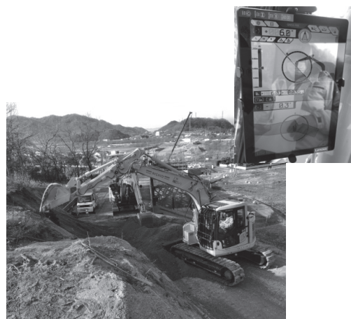
図-6 仮設道掘削へのICT施工適用状況
