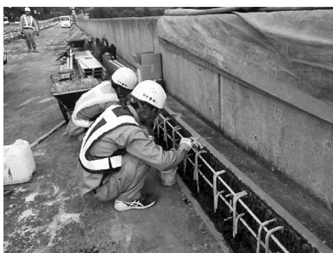
図-3 鉄筋防錆材塗布状況
