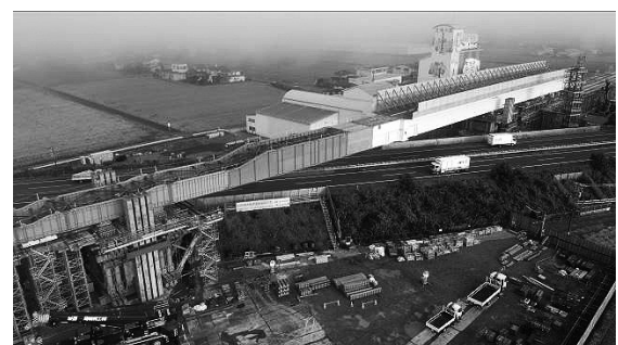
図-10 第1回桁送出し架設完了
