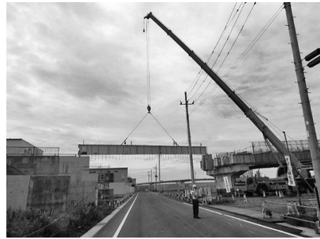
図-4 主桁架設状況
