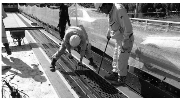
図-9 縦目地伸縮装置設置状況
