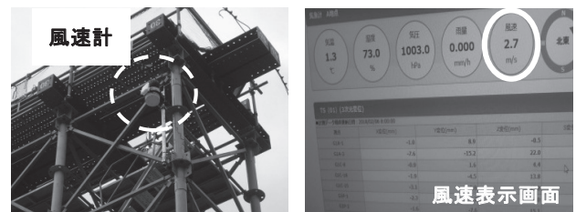
図-5 風速計設置状況 図-6 風速監視画面
