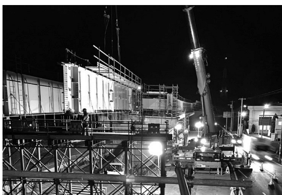
図-5 P4～P8架設状況
