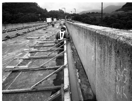
図-4 コンクリート打設状況
