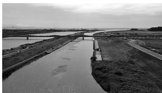
図-1 現場全景写真
