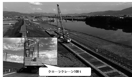
図-1 クレーン足場に敷鉄板
