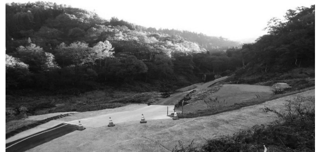
図-7 道路改良後
