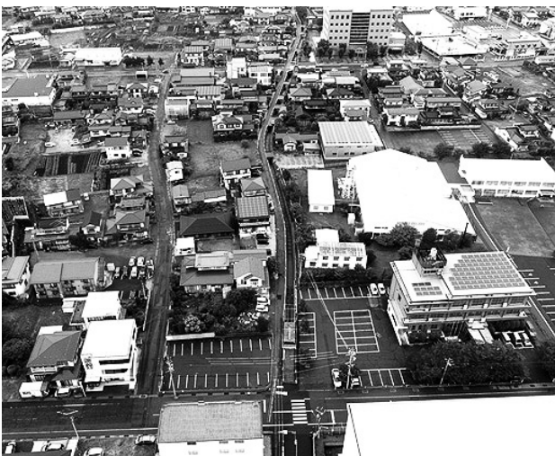
図-1 施工箇所着手前
