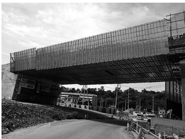
図-2 足場、防護組立全景
