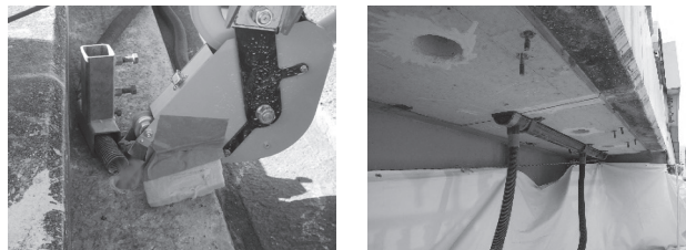
図-4 ワイヤソー切断部養生状況
