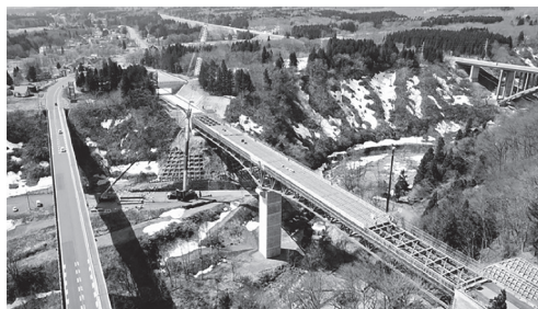
図-5 合成床版架設状況
