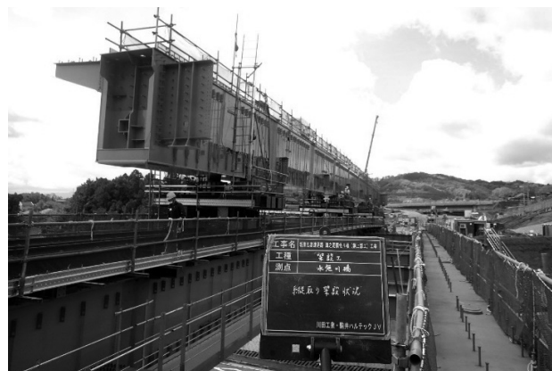
図-4 縦取り架設状況
