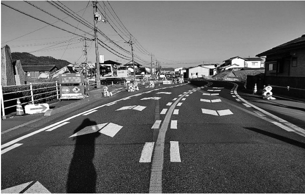
図-2 安全施設設置状況
