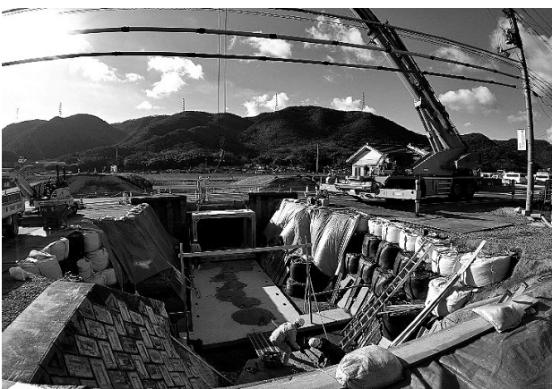
図-3 土留工 鉄板・大型土のう設置
