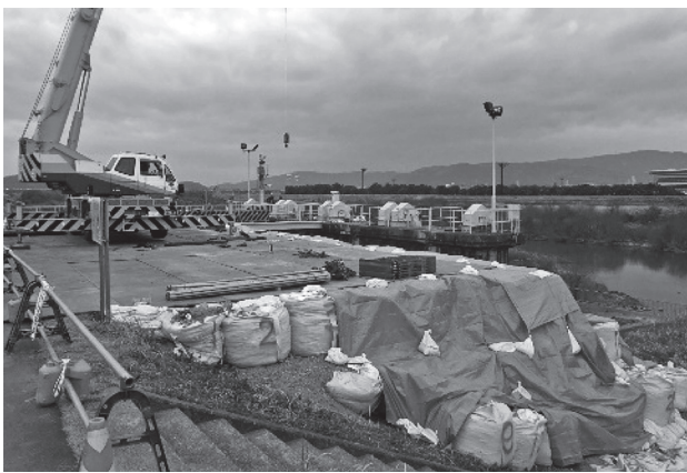
図-7 クレーン盛土造成完了
