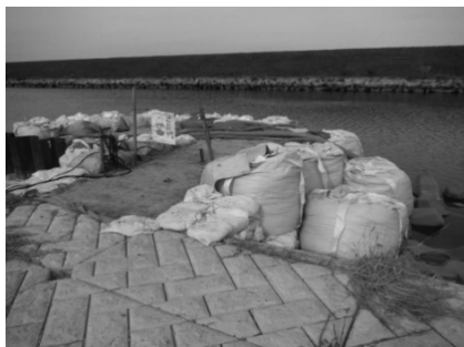
図-2 大型土のうによる仮締め切り
