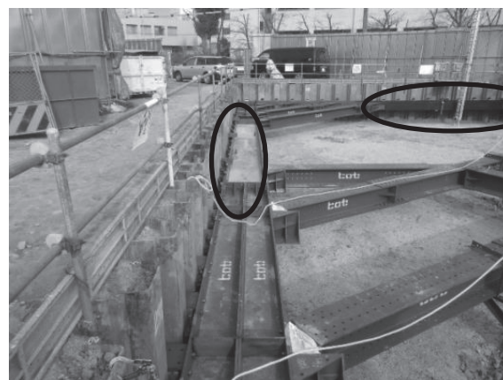
図-1 高強度腹起し設置
