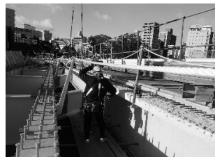
図-7 縦桁架設状況
