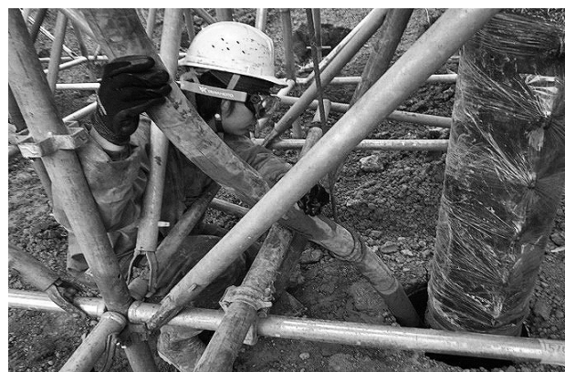
図-5 モルタル注入作業
