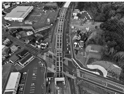
図-8 J18～J21落とし込み架設
