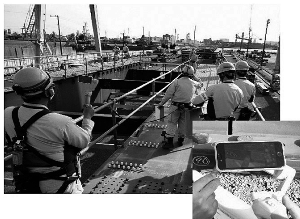
図-2 対物検査状況
