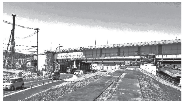
図-5 A2到達バントとP4作業ヤード
