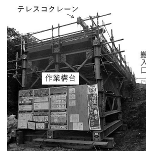
図-4 作業構台
