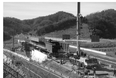
図-4 現地施工状況
