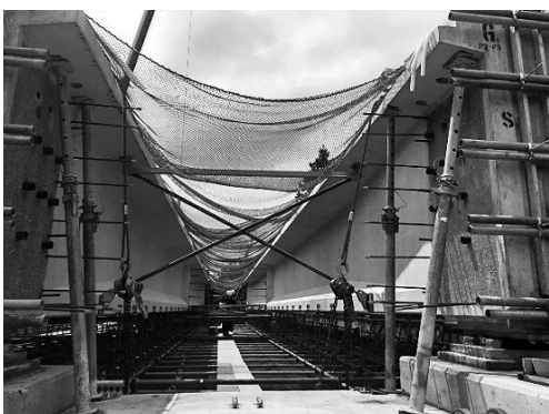
図-3 対傾構による転倒防止
