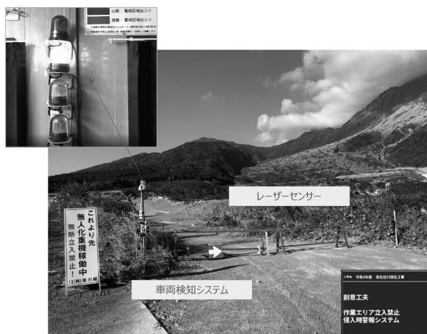
図-8 車両検知システム
