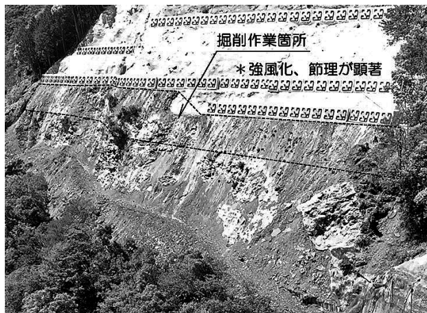
図-3 掘削作業箇所
