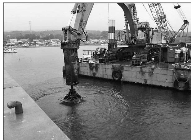
図10 既設基礎捨石天端撤去・捨石投入後、本均しタンピング状況
