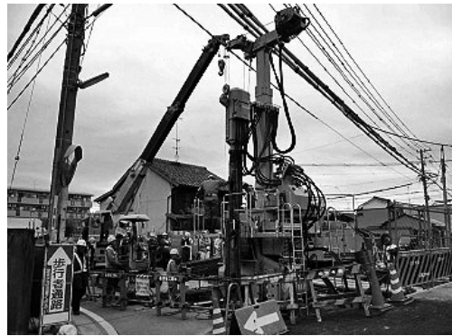
図-1 施工例写真 (ハンドリングシステム工法)
