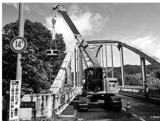
図-5 ミニクローラー型クレーンによる吊り込み作業図
