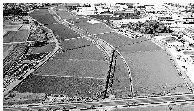
図-3 現場状況 (完成)
