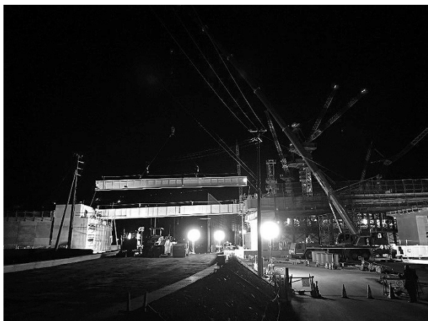
図-3 主桁架設作業状況
