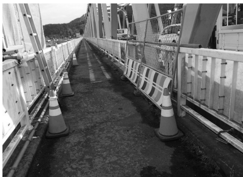
図-2 地覆撤去箇所フェンス設置
