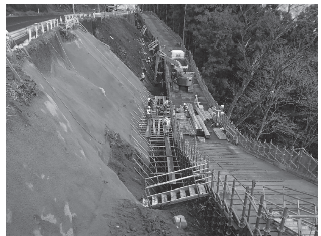
図-5 法面作業構台を利用する作業
