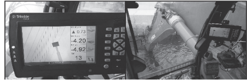
図7 GNSSによる施工状況 モニターに3次元データが表示される
