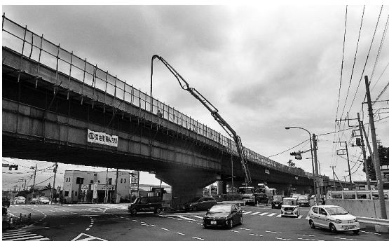
図-10 P8～A2コンクリート打設状況
