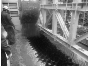
図-5 基礎碎石(ジオセルマットレス)状況
