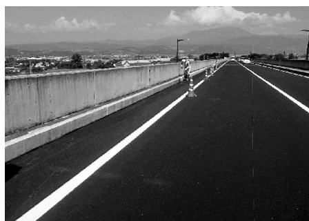
図-5 コンクリート表面保護状況
