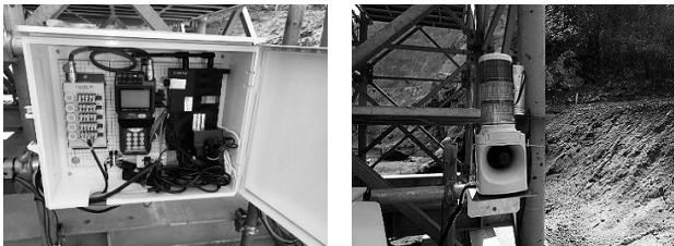
図-3 データロガーとモデム・回転灯
