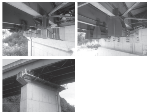
図-3 施工完了写真
