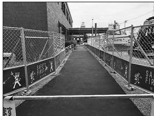
図-4 仮舗装による仮設通路
