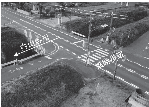
図-3 着工前 横断歩道
