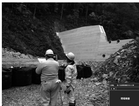
図-5 ノンプリズムTSでの確認
