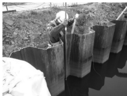
図-3 スズランテープ施工
