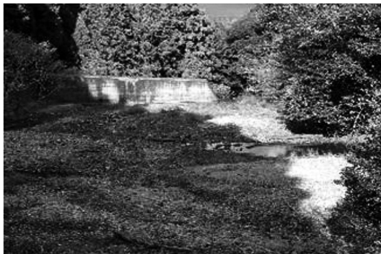
図-1 福德川砂防堰堤 堆積土砂状況
