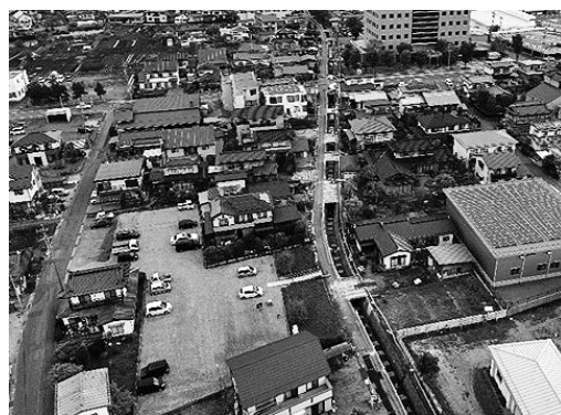
図-4 代替駐車場設置
