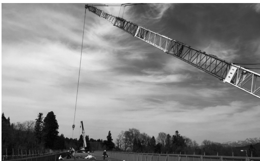
図-6 550tATC使用による鉄筋運搬
