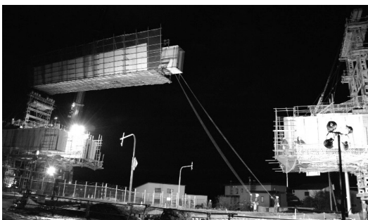
図-14 落とし込み架設状況
