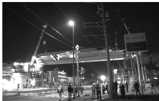
図-10 夜間一括架設状況（国道32号上）
