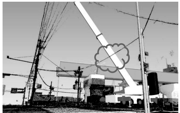
図-8 クレーン稼働範囲内における干渉物確認
