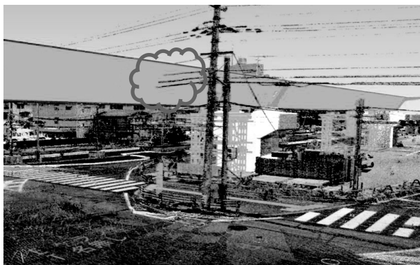
図-9 桁と架線の干渉
