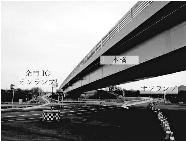
図-2 架設地点の状況
