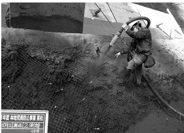
図-8 モルタル吹付状況
