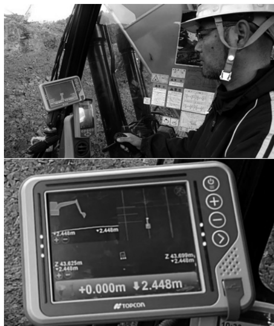
図-6 ICT建設機械内モニター確認状況
