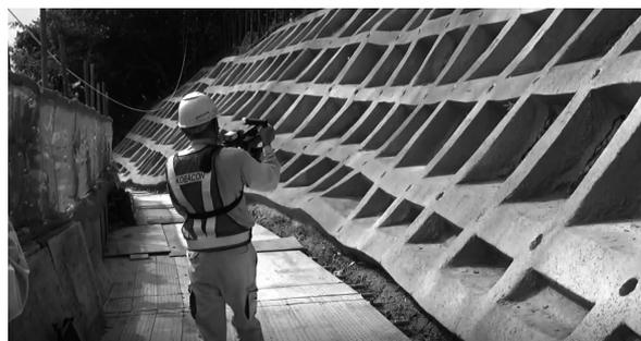
図-10 歩測式スラムレーザー手法
